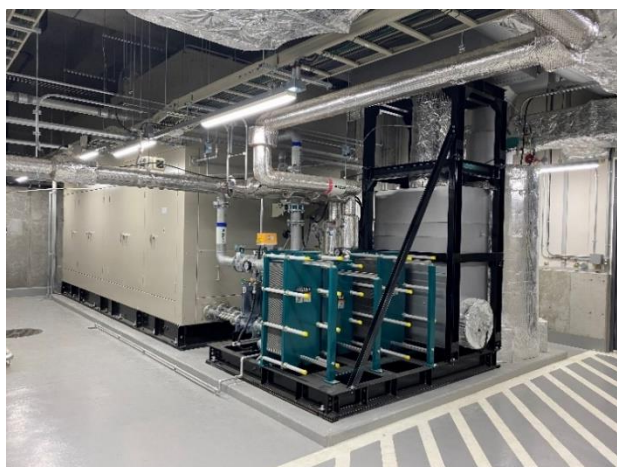
CGS 現地外観
